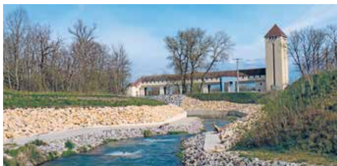
Passage à poissons du barrage de Jons
